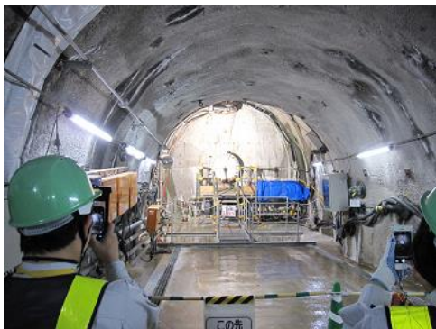
図 1 3 地下 500m の坑道
